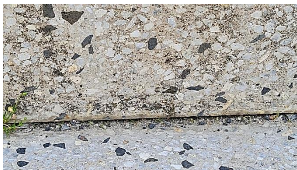
Obrázek 6 – Pohled na mezeru mezi bet. stupni
