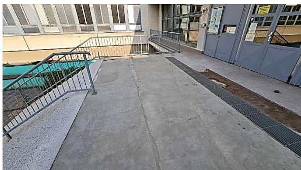
Obrázek 3 – Pohled na dilatační spáru na podestě
