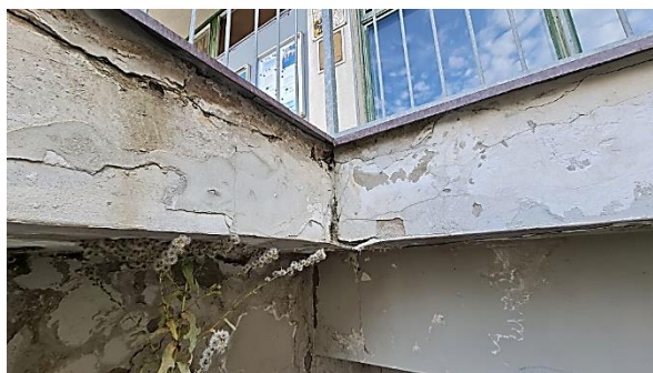
Obrázek 7, 8 – Pohled na korozi betonu a výztuže a dožilé omítky zděných stěn
