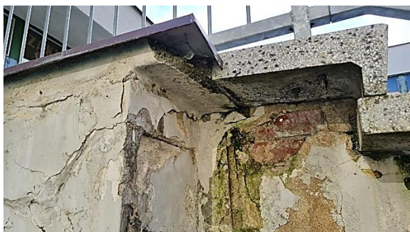
Obrázek 7, 8 – Pohled na korozi betonu a výztuže a dožilé omítky zděných stěn
