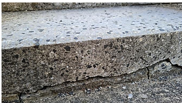
Obrázek 5 – Pohled na poškozený bet. stupeň
